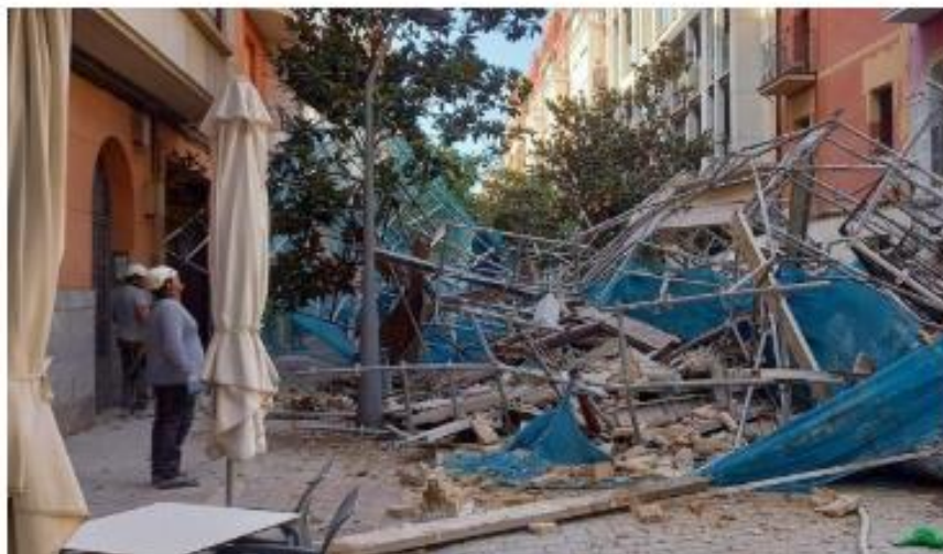
Derrumbe en la obra
